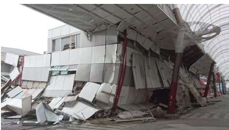
建物倒壊によりアーケードの柱が曲る
