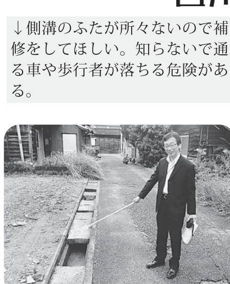
↓側溝のふたが所々ないので補修をしてほしい。知らないで通る車や歩行者が落ちる危険がある。
