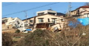
基礎が剥がれ横転した住宅
